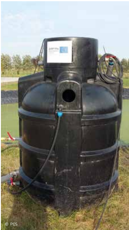
Reactorvat van de MBBR
