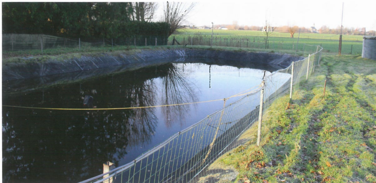
In het waterreservoir van 250 m 3 vangt kamerplantenteler Meuninck het drainwater op dat hij in het voorjaar en de zomer over het land verspreidt.
