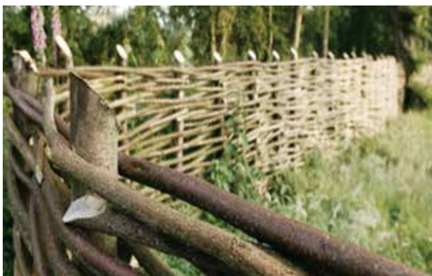
Twee dergelijke lage houtschermen worden gevlochten en op een afstand van 40 tot 50 cm van elkaar geplaatst. De tussenliggende ruimte wordt opgevuld met een los verband van snoeihout. © Schutting-info.nl
