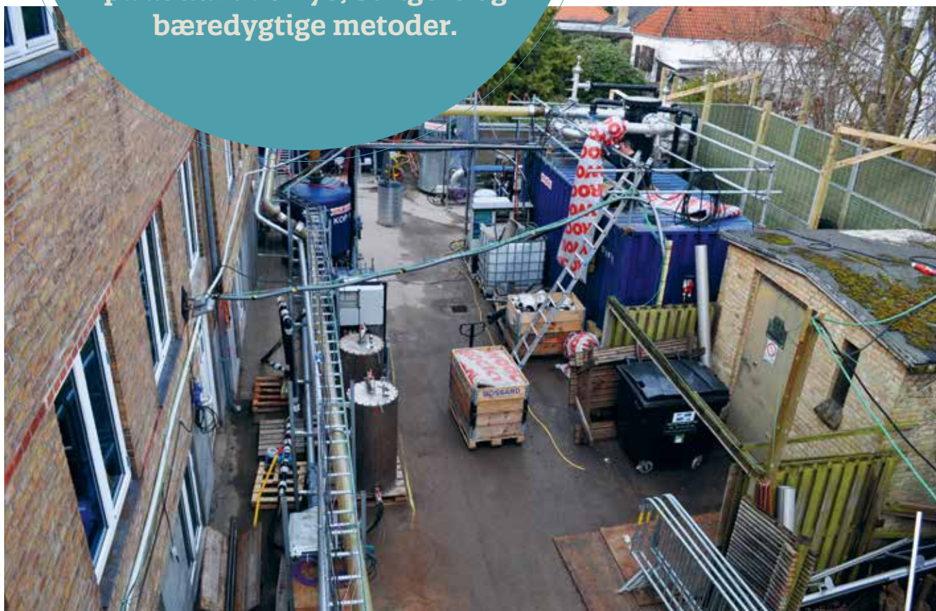
Det ligner et "Storm P-anlæg", men det er det ikke. Det er termisk oprensning. Når jorden er opvarmet, bliver forureningen til damp, der kan suges op af jorden og renses.
